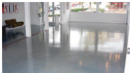
Lorsqu'une résistance exceptionnelle aux produits chimiques, à l'abrasion et aux chocs est nécessaire, le revêtement à l'époxy polyamide (V400) conviendra parfaitement.
