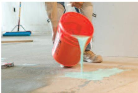
l'adhérence entre l'autolissant et le support contribue à l'obtention de la surface la plus lisse possible en maximisant le temps d'écoulement (voir photo 8) et améliore les propriétés autoréparatrices
