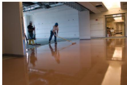
Les utilisateurs expérimentés préfèrent appliquer les matériaux autolissants à l'aide d'une pompe plutôt que de les mélanger avec une perceuse.
