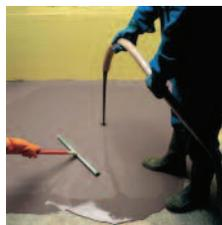
Comme c'est le cas avec n'importe quel matériau de resurfaçage, il est très important de bien préparer le support afin d'éviter les conséquences fâcheuses liées à une mauvaise performance du produit, ou encore à une défaillance complète du système.
